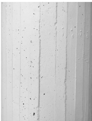
Säule aus Gussbeton mit sichtbarer Holzverschalung
